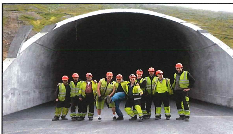
Malbikun Héðinsfjarðarganga lokið haustið 2010
